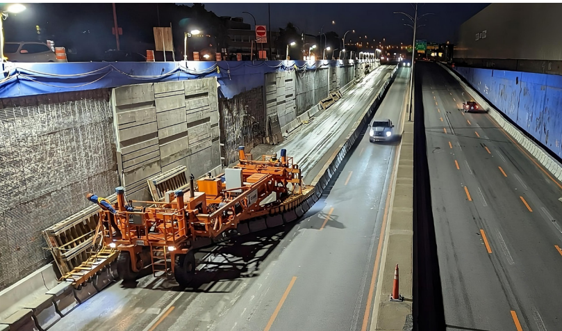
Réhabilitation des murs en béton
