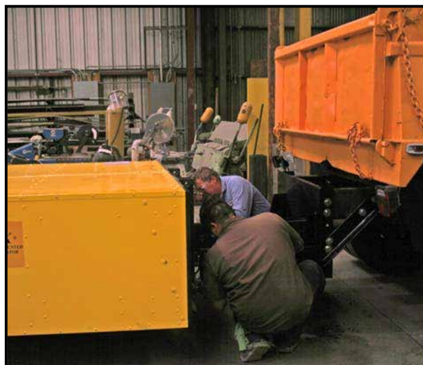
Figure 10. Boulonnage de l'AIFV au palier de support.
