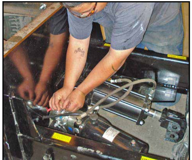
Figure 14. Branchement sur la structure de support effectué.
