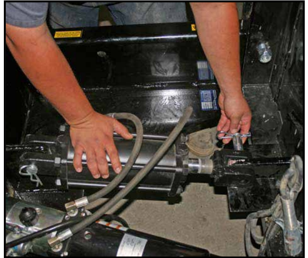
Figure 12. Installation du vérin de levage.
