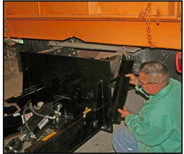
Figure 7. Installation des contre-fiches latérales.
