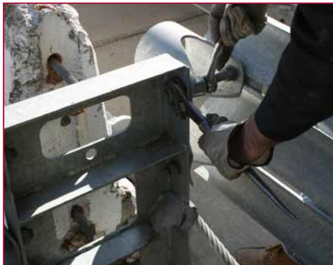
Retrait des boulons des panneaux de tuyau
