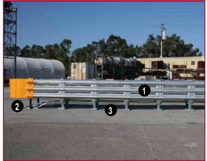
1. Vérifiez qu'il n'y a pas de trace de pneus ou de marque de peinture à l'avant et sur les côtés du système. En outre, vérifiez que les panneaux ne sont pas tordus ou délogés.
