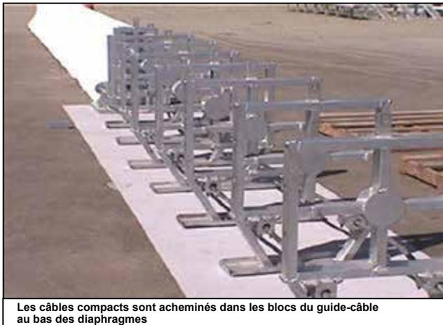
Les câbles compacts sont acheminés dans les blocs du guide-câble au bas des diaphragmes
