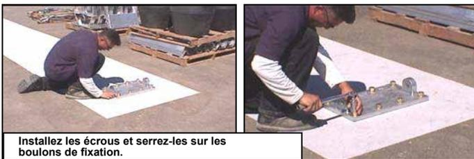
Installez les écrous et serrez-les sur les boulons de fixation.
