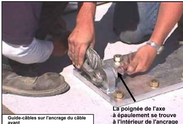
Guide-câbles sur l'ancrage du câble avant
